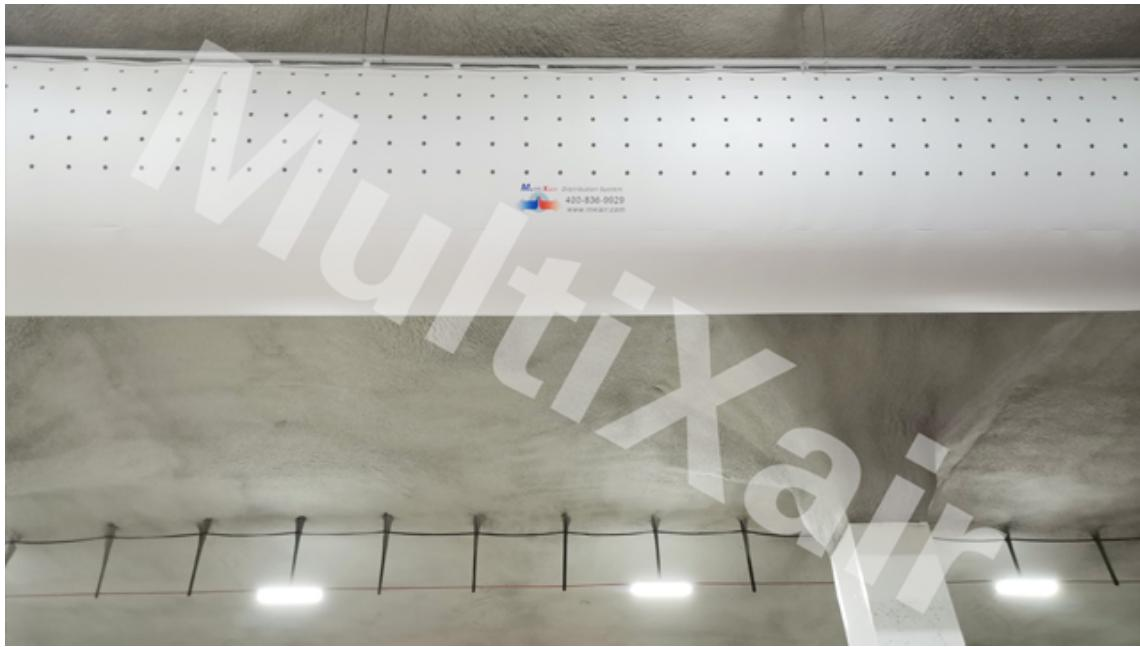
冷冻加工项目冷库项目设计概况本工程为低温冷库内部温度保持在-20℃，内部净高15m，建筑面积5469.04m<sup>2</sup>。南北长99.8米，东西长54.8米，采用九台冷风机，单台风量为43976m<sup>3</sup>/h。采用织物静压箱加水平织物风管的送风方式。项目需求：1：织物风管高度要求，占用空间高度低，位于货架上方，对风管本身和货架无影响；2：外观整洁美观；3：重量轻，方便安装；4：不对建筑结构造成破坏，减轻建筑结构的负荷。项目设计概况本工程为低温冷库内部温度保持在-20℃，内部净高15m，建筑面积5469.04m<sup>2</sup>。南北长99.8米，东西长54.8米，采用九台冷风机，单台风量为43976m<sup>3</sup>/h。采用织物静压箱加水平织物风管的送风方式。
