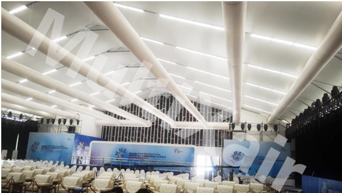
MX织物风管具有特殊性，本身就是一个静压箱装置，不需要额外的增加静压箱设备；我们的设计师在设计阶段就根据设备的各项参数对MX织物风管进行包括规格、气流风速、出风风速、出风均匀度、渗透率等进行了设计和通过CFD模拟软件进行模拟安装后运行特性。因此，无需在空调设备上增设调节装置。MX织物风管是一种柔性材料，运行过程中不会像传统风管般产生巨的噪音，因为是柔性材料，反而会吸收一部分的噪音。在人们对环境要求越来越高的趋势下，织物风管送风获得青睐。织物风管，就选米希（上海）环境技术有限公司，有需要可以联系我司哦！吕梁纤维织物风管厂家
